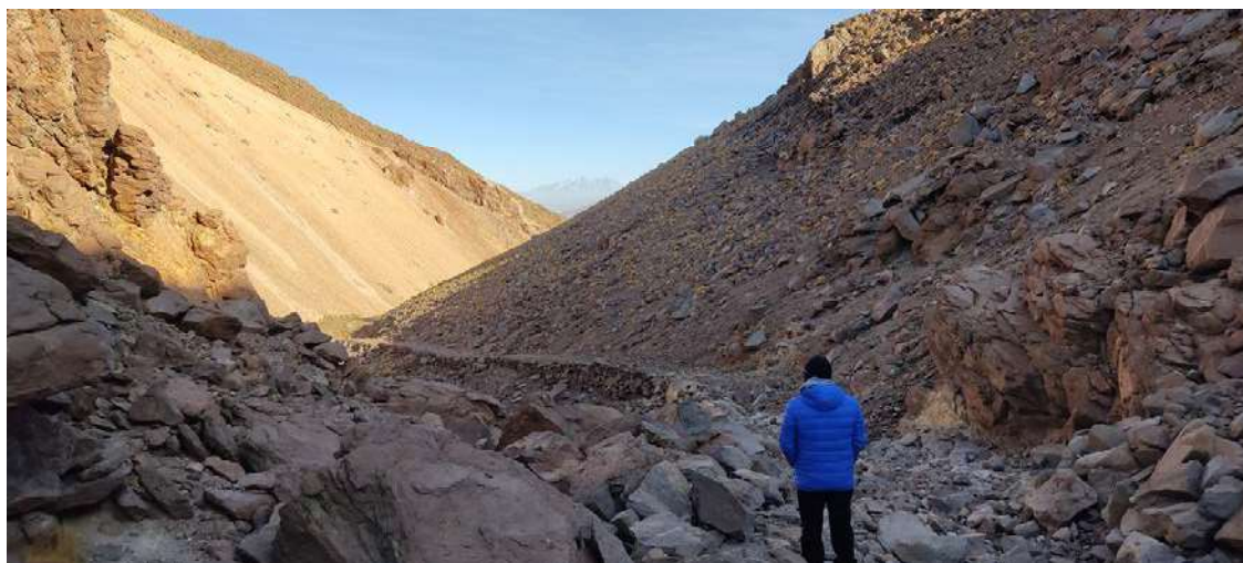
Figura 8. Camino del Inca con calzada elevada y muro de contención en quebrada del Inca, al sur de Chac-Inga (UTM 589645N-7590880E; 4233msnm)
