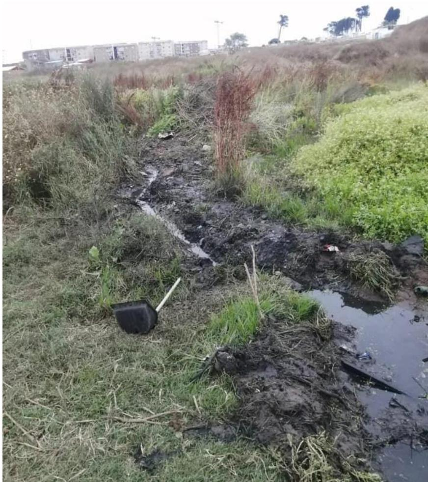
Surco realizado en la primera intervencion del dia 07 de febreo de 2021 utilizando palas, chuzos y otros elementos para desviar el agua del espejo de agua existente. Se puede observar la intervencion
