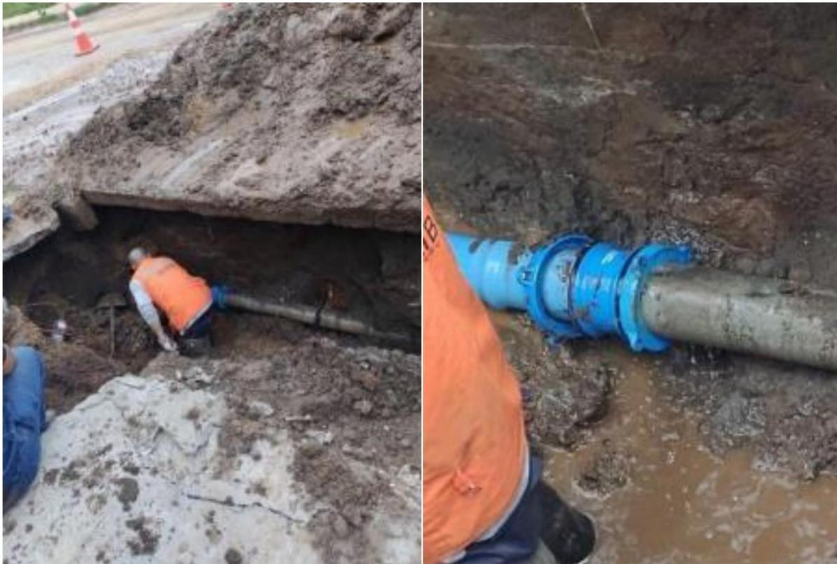
Fotos 1 y 2. Representan los trabajos realizados por esval para cerrar la filtración de agua potable.
