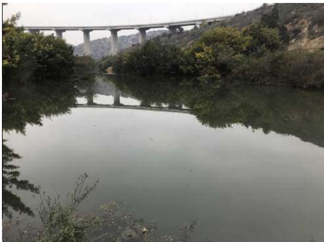
Anexo imagen 13. Vista general humedal sector viaducto Troncal Sur
