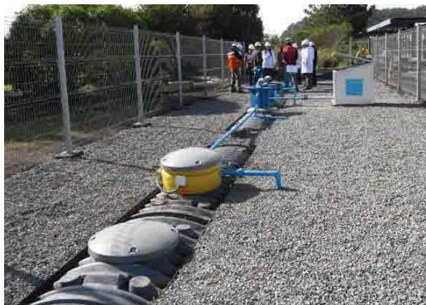
**Figura 121.** Aspecto general de un posible sitio de descarga de camiones limpiafosas consistente en fosas sépticas enterradas y sin aguas servidas expuestas. Reproducido del sitio web de Bio Agua Tr Ltda., plantas de tratamientos.
