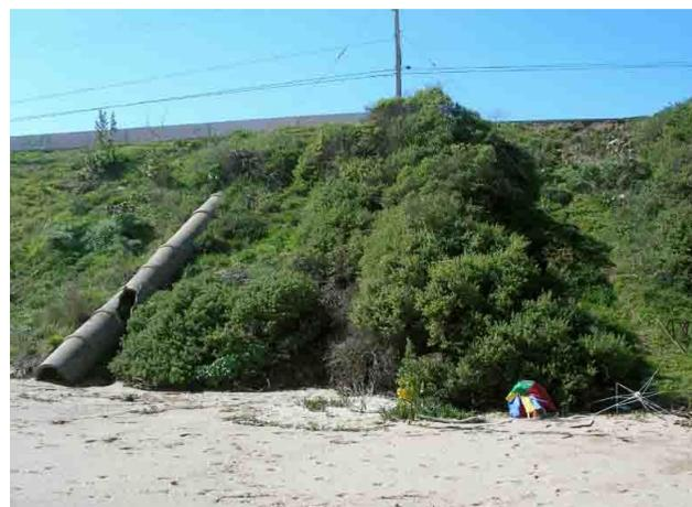
**Figura 189.** Terraplén en el costado sur del puente de Córdoba visto desde la playa Las Ágatas, con ubicación de la futura escala peatonal a la ruta costera G-98-F al costado del tubo de evacuación de aguas lluvia visible a la izquierda (ver punto 7 en la Figura 178). Agosto de 2013.
