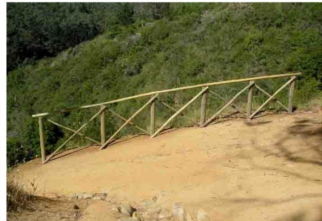
**Figura 174.** Baranda para mejorar las condiciones de seguridad en el zigzag de acceso a la Quebrada de Córdoba. Noviembre de 2014.
