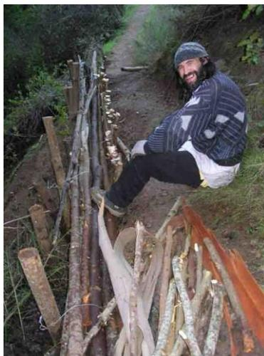
**Figura 80.** Obra de recuperación de sector erosionado en el sendero de la tubería de la Quebrada de Córdoba. Junio de 2010.
