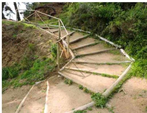
**Figura 166.** Obra que evita la erosión en curva del zigzag de acceso a la Quebrada de Córdoba. Septiembre de 2017.
