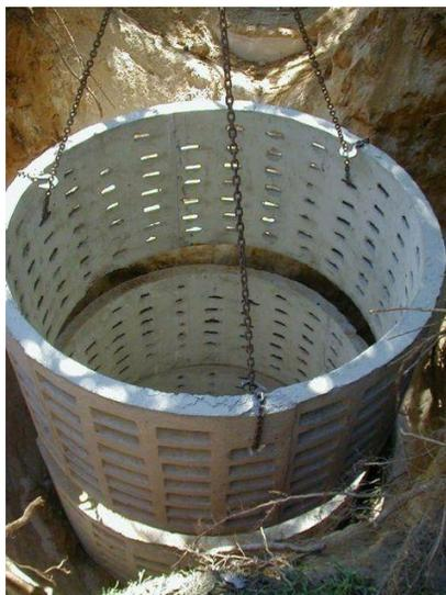
**Figura 112.** Sumidero de agua en construcción formado por anillos perforados en cuyo interior se depositarán piedras.
