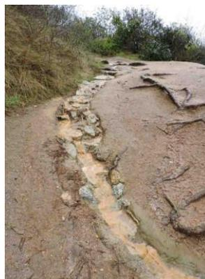
**Figuras 167, 168 y 169.** Encauzamiento de las aguas lluvia con el fin de evitar la formación de cárcavas en el zigzag de acceso a la Quebrada de Córdoba. Izquierda y centro, julio de 2016. Derecha, junio de 2019.
