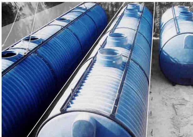
**Figura 120.** Conjunto de fosas sépticas de gran capacidad unitaria (50 m<sup>3</sup> c/u) en proceso de ser instaladas en forma subterránea. Reproducido de Infraplast, manual de instalación, mantención y operación de estanques.
