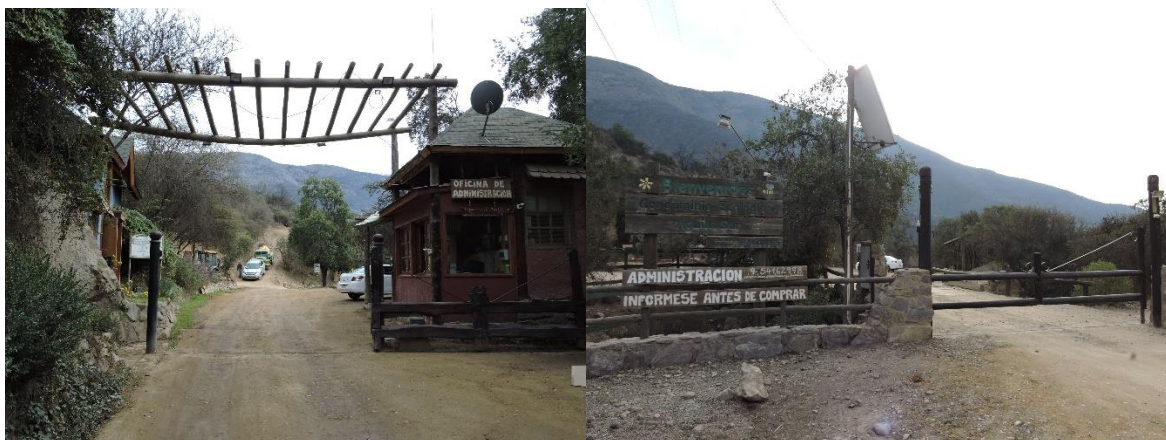
Figura 7. Portón con caseta (izquierda) y portón interior (derecha)
