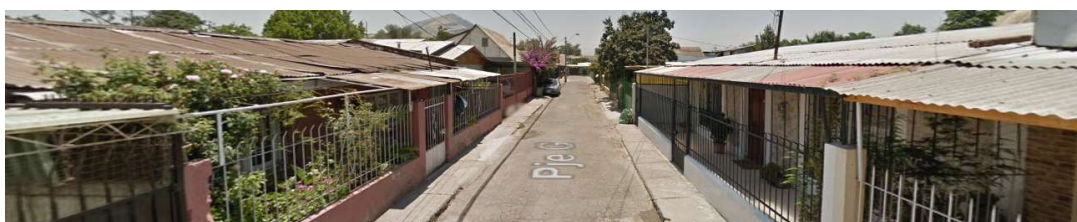
Imagen N°34: “Casas en población Barea”. Fuente: (Street View, 2012).
