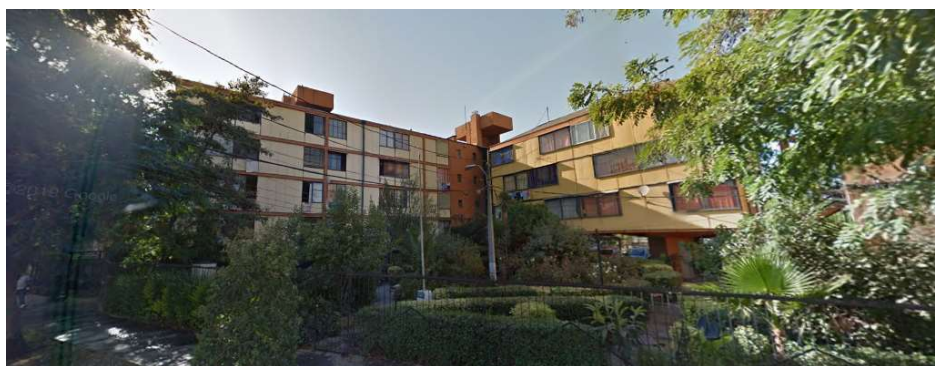
Imagen N°32: “Edificios en Villa Ríos”. Fuente: (Street View, 2012).
