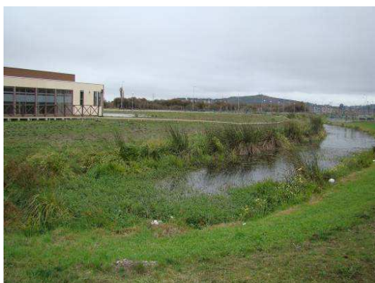
Tramo del canal en el sector Carriel Sur cercano al casino Marina del Sol.
