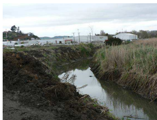
Canal que limita el desarrollo del humedal (recuperación de su área original), con el fin de evitar que las aguas inunden sectores industriales y residenciales aledaños.
