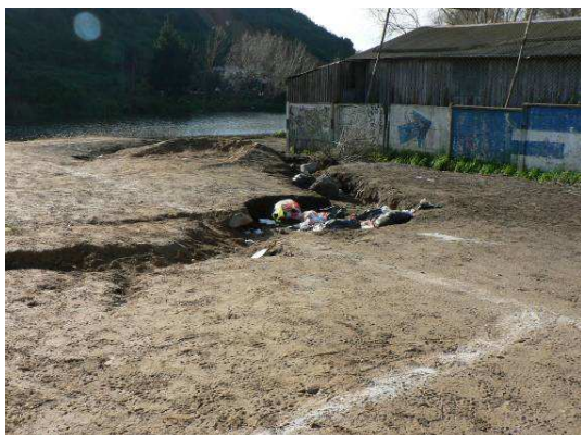
Los procesos de rellenos con escombros y sedimentos sin un programa de recuperación de riberas, permite que las lluvias provoquen la formación de cárcavas con la consecuente erosión de sedimentos arrastrados hacia la laguna y aparición de basuras en ellas.
