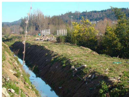
Presencia de canales de drenajes hechos para drenar el agua del humedal y construir casas sobre el mismo.
