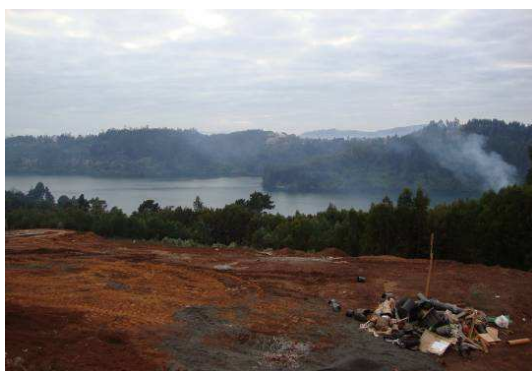
Trabajos de despeje de vegetación y construcción en la cuenca de drenaje de la laguna
