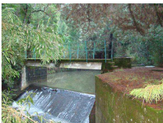
Embalse generado para la captación de las aguas.
