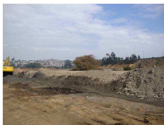
Trabajos de relleno en el humedal entrada a Lota.
