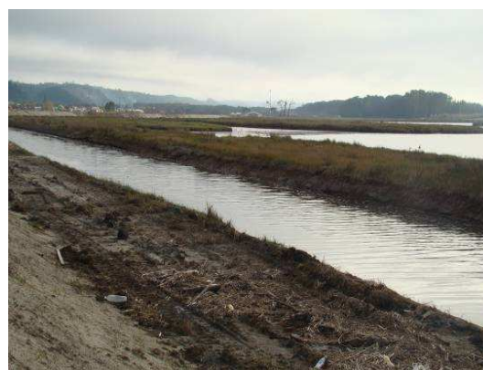
Canalización de un sector del estuario.
