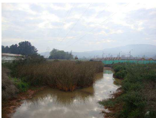
Canalización para el drenaje del humedal Coronel.
