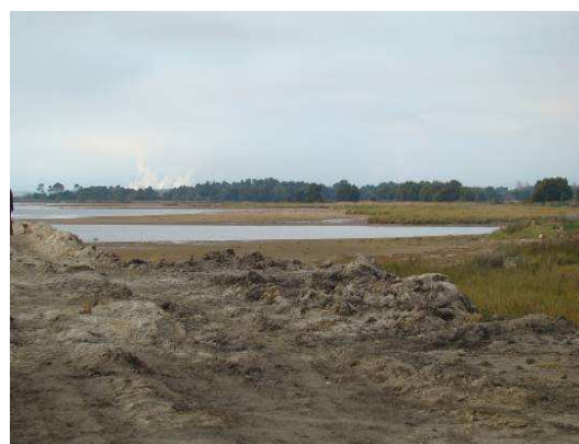
Rellenos de tierra en el humedal.
