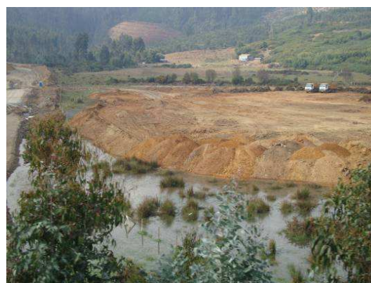
Los rellenos abarcan más del 80% del humedal que se asociaba al estero Manco, el cual se ha transformado en un patio de camiones.
