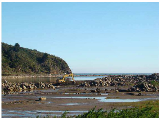
Obras de implementación de diques en la desembocadura, donde se aprecia además que se trabaja sobre un área de inundación asociado al cambio de marea, con el consecuente riesgo posterior que significa la colonización de personas de estas áreas de rellenos.
