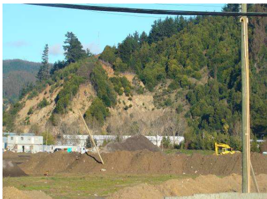
Actividades de relleno en las inmediaciones del humedal Andalién, vecino a Valle Noble, ciertamente también un relleno de la llanura de inundación.
