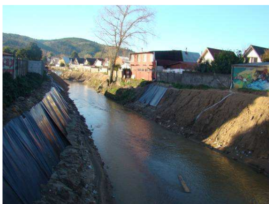
Obras de encauzamiento del Estero Nonguén.
