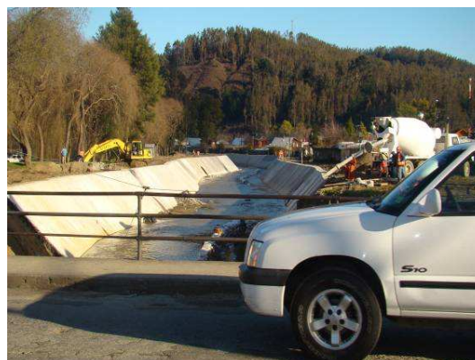
Encauzamiento y revestimiento de márgenes del estero Nonguén.
