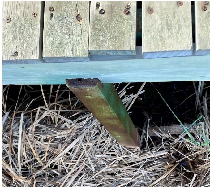
Figura N°12: Soporte oxidado en terraza 2. Fuente: Elaboración Propia.
