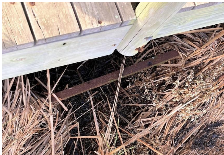
Figura N°11: Soporte oxidado en terraza 1. Fuente: Elaboración Propia.
