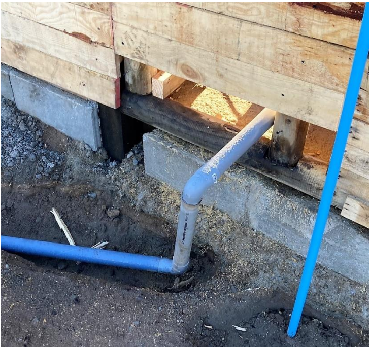
Figura N°16: Comienzo tubería de aguas grises en el Quincho. Fuente: Elaboración propia.
